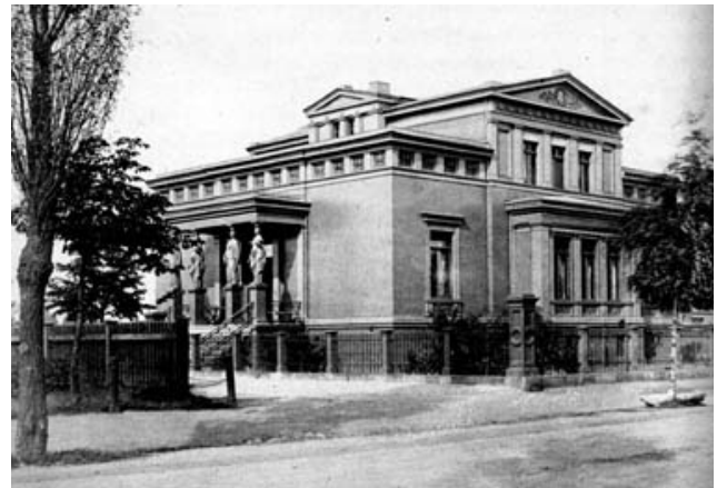
Willa Friedricha W. Grundmanna (przed rozbudową) w Katowicach - wyburzona w latach 70-tych XX w.
